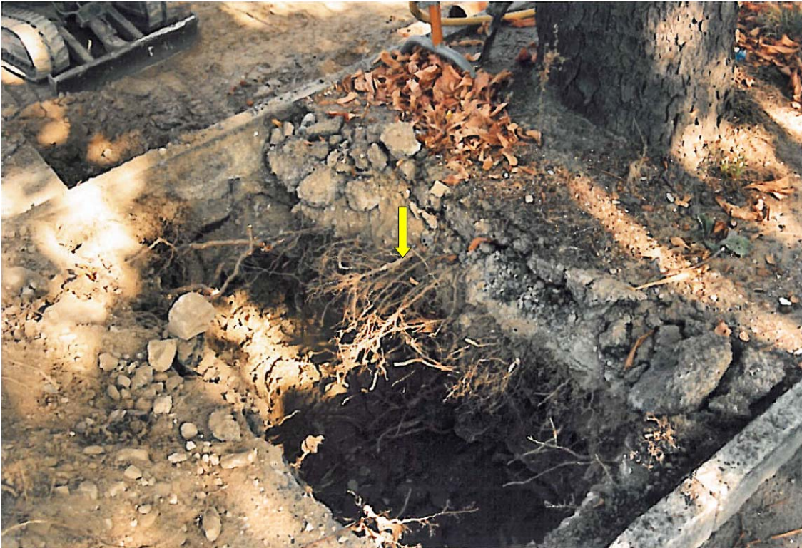
Foto 5: Immagine della Sezione del Verde Pubblico, Lugano, 1989: Trincea nello spartitraffico. Anche se a distanza di solo ca. 1m dal tronco, non sono visibili delle radici grosse!
