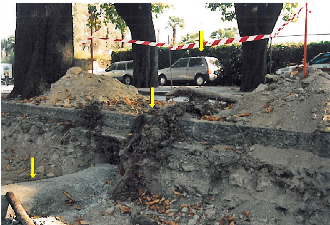
Foto 3: Immagine della Sezione del Verde Pubblico, Lugano, 1989: Scavo sulla corsia a nord e creazione di trincee passanti attraverso lo spartitraffico. Probabilmente la condotta visibile esisteva già quando è stata realizzata la corsia a nord. Evidentemente il largo marciapiede sotto la fila di alberi a sud serviva, almeno a tratti, da posteggio.
