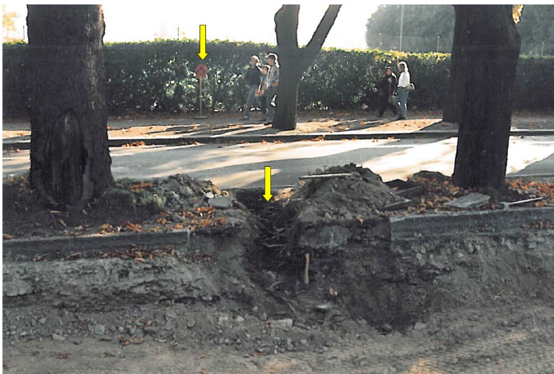
Foto 4: Immagine della Sezione del Verde Pubblico, Lugano, 1989: Creazione di trincee nello spartitraffico con la presenza di radici medie e fini danneggiate, ma senza radici grosse. Il cartello mobile di "divieto si sosta" posizionato sul marciapiede sotto la fila di alberi a sud indica l'uso abituale come posteggio.
