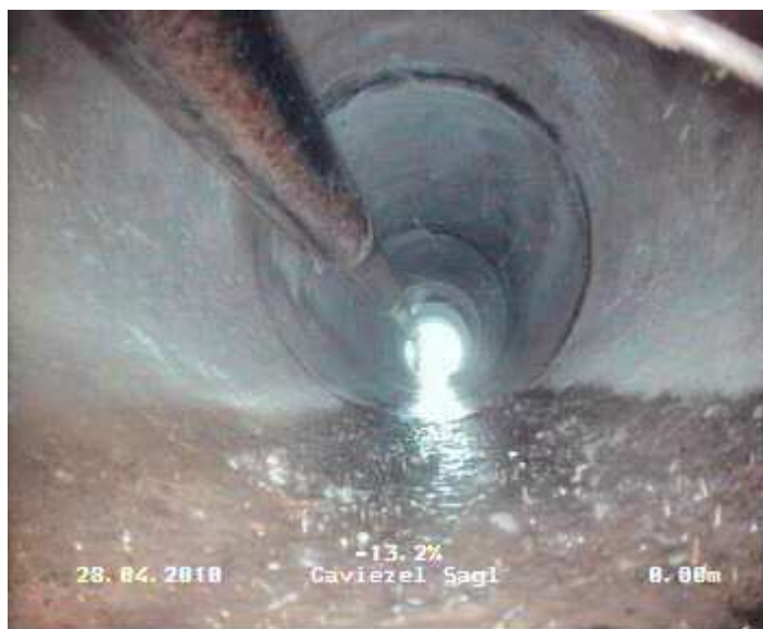
Infrastrutture interne alle canalizzazioni
