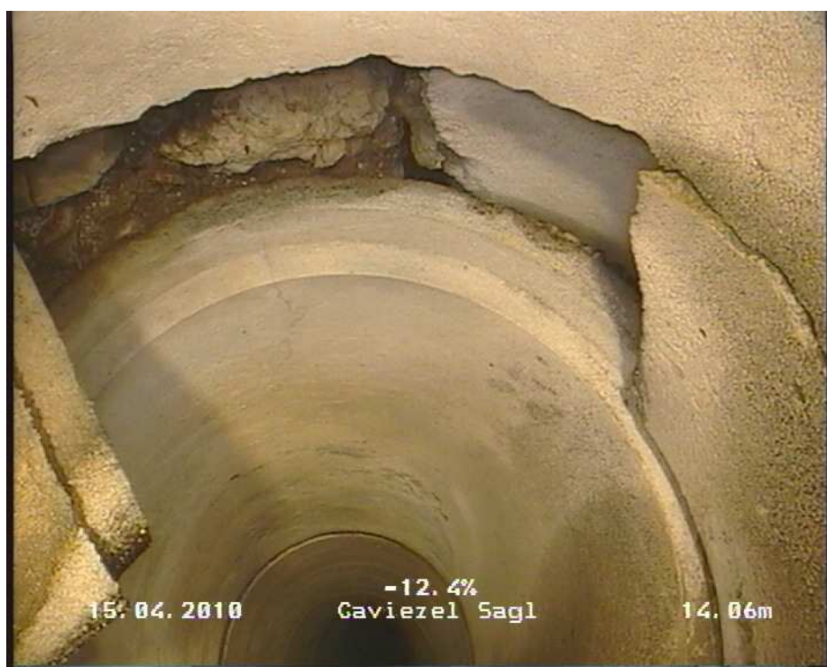
Canalizzazioni - rotture
