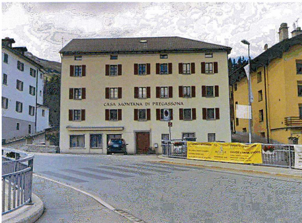
Casa Montana San Bernardino
