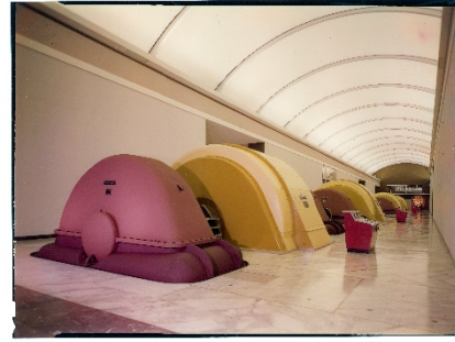
Diga del Luzzone, sala delle macchine nella centrale di Biasca, 1965
