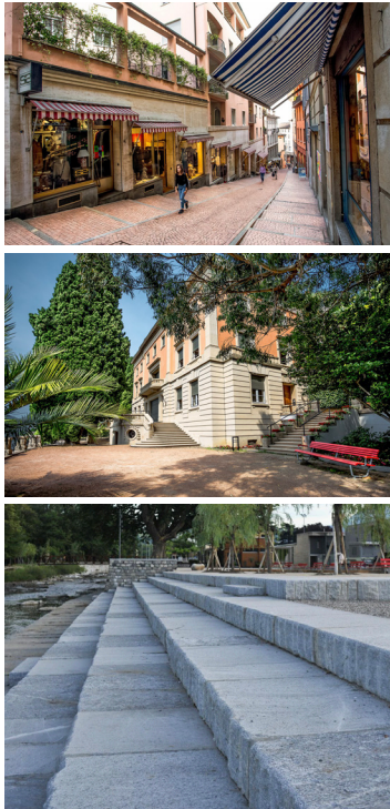
Foto dall'alto verso il basso: Pavimentazione a cubetti in porfido rosa di Cuasso al monte alla salita Cattedrale, Lugano. Pavimentazione in calcestre di por- fido rosa di Cuasso al Monte a Villa Heleneum, Lugano. Scalinata realizzata con blocchi d'arginatura grezzi, fresati e fiammati in Gneiss ticinese alla Foce del Cassarate. Progetto e foto: © Officina del Paesaggio
