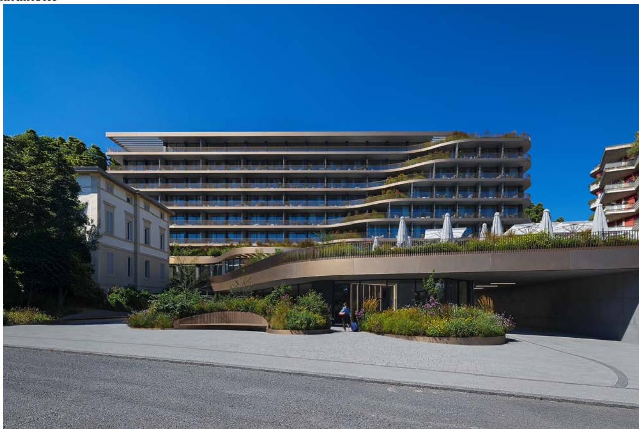
Vista frontale da via Cassarinetta del nuovo complesso alberghiero.
