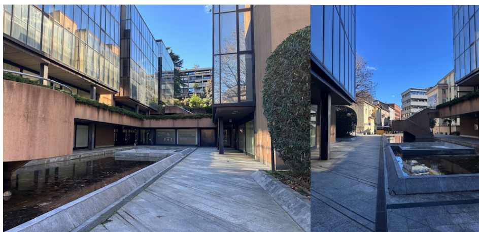
Zona portale RTTL lato Lugano
