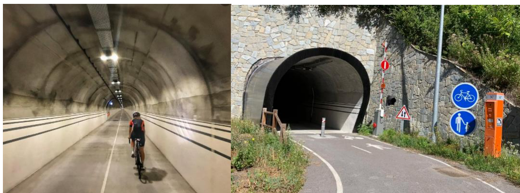
Portale e cunicolo bici di Siaix (Albertville, F)
